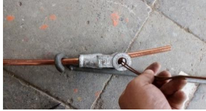
BNのボルト穴へ (トローリー線の下側)
