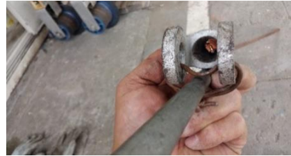
⑤ なまし線を通したら
