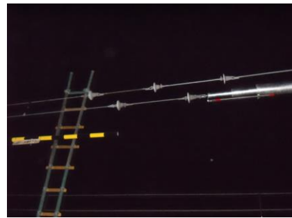
ばねバランサー架線取付け後
