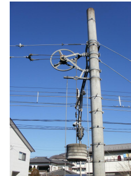
作業前(柱の状態)
