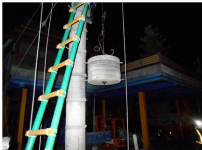
重錘 重り枠取外し後
