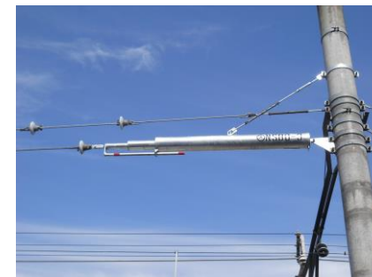
(完成)支線移動・付帯設備撤去後
