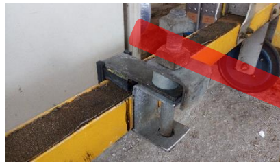
連結棒を取付けてナットで固定する。
