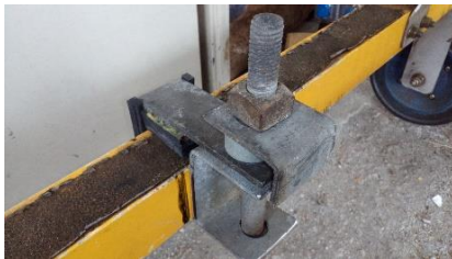
連結棒を取付けてナットで固定する。
