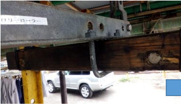
取付け固定する。
